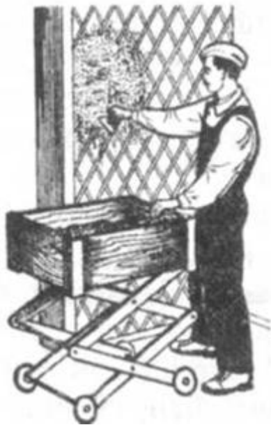
Рис. 4. Накидання штукатурного розчину кельмою з ящика
