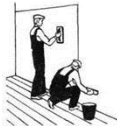
Рис. 5 . Організація робочого місця штукатурка під час загладжування штукатурки
