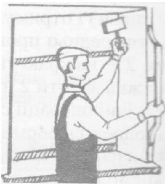
Рис.3. Встановлення форми на кутку та її припресування
