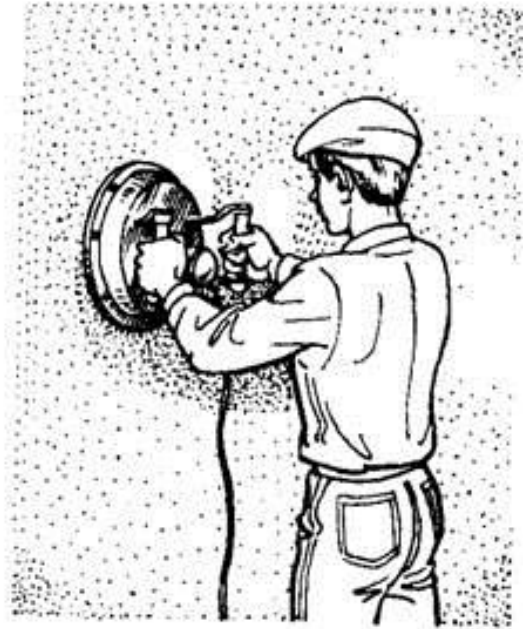
Рис. 3. Механізоване затирання накривного шару штукатурки
